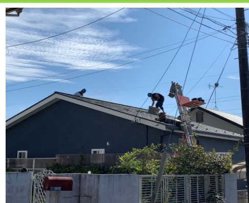
太陽光&蓄電池設置工事☆ 初期投資が多少かかりますが、 月々の電気代がうふふふ。
