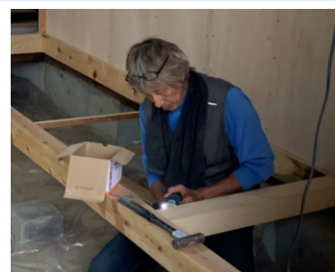
藤野さん☆ 大引きが通るように長さ調 整し、なおかつ直角になる ように確認してとめます。
