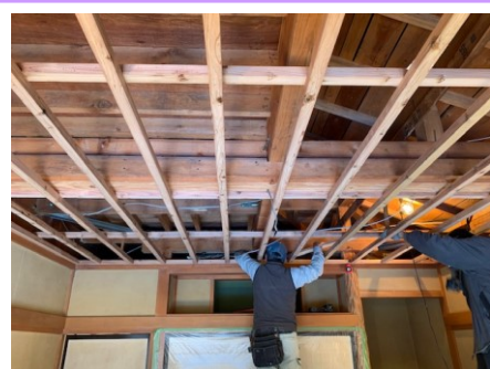
和室から洋室にするため、 天井を交換しています。
